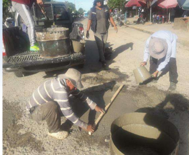
FOTOGRAFIAS DE BACHEO DE AVENIDAS Y CALLES
